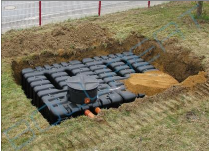
Afbeelding 2: Ondergrondse regenwatertank (Bollaert, 2017).
