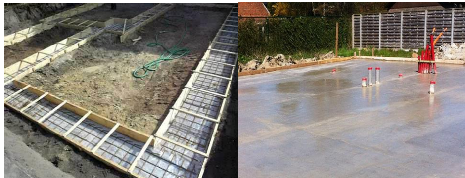
Figuur 43 – Strokenfundatie in afwachting van storten, plaatfundering
