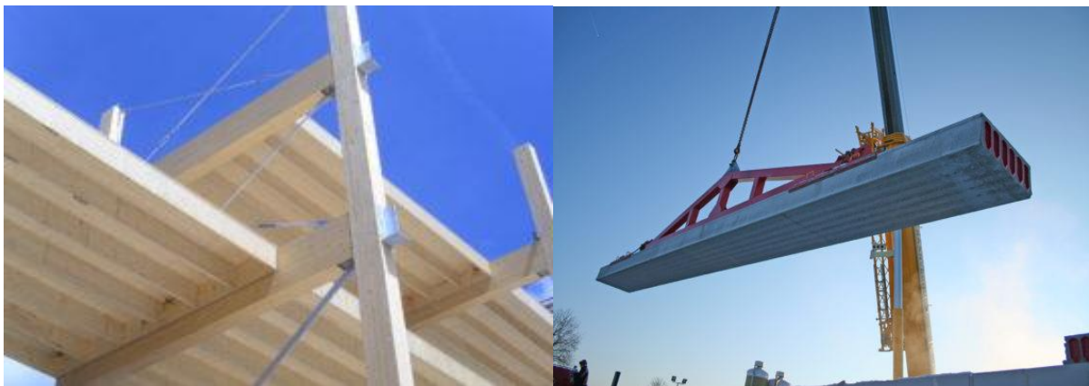
Figuur 45 – Vuren houten balklaag als liggers, kanaalplaatvloer
