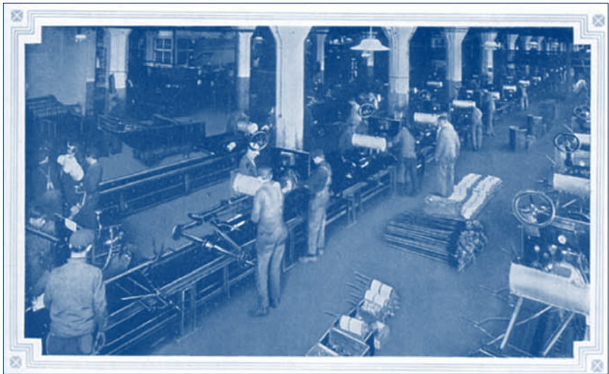
De assemblagelijns bij Ford (ca. 1915, Highland Park Plant), inspiratie voor grondleggers van het Toyota Production System
